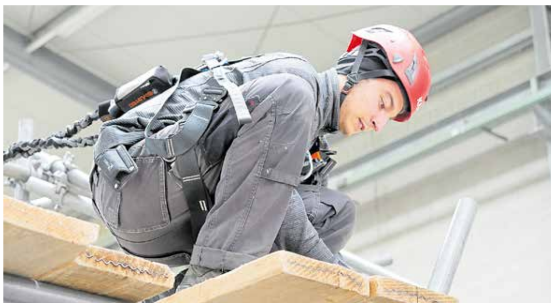
Ein Gerüst planen, ausführen, vermessen und dokumentieren – Gerüstbauer Patrick Stiefel bewältigte diese Aufgaben beim Bundeswettbewerb mit Bravour.
