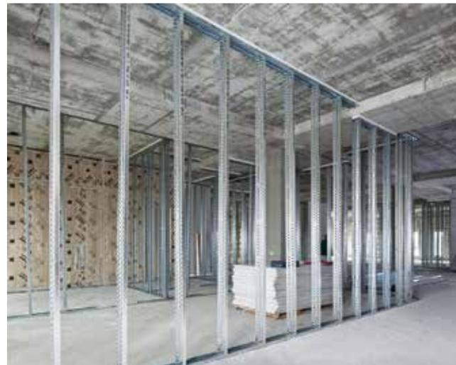
Neuartiges Schnitt- und Faltverfahren zur Herstellung von Trockenbauprofilen (Preisträger 2013: Protektorwerk Florenz Maisch GmbH & Co. KG)
