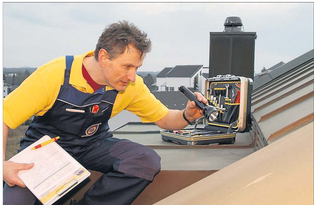
Der Dachcheck gehört zu den begünstigten Handwerksleistungen. Bild: ZVSHK
